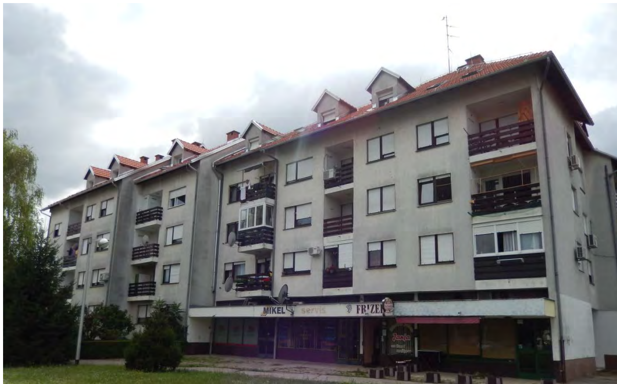
Slika 6: SZ i JZ pročelj stambene zgrade
