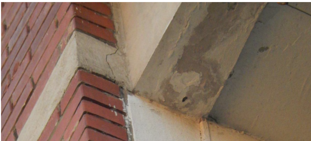
Slika 3: Vanjski zidovi stambene zgrade
