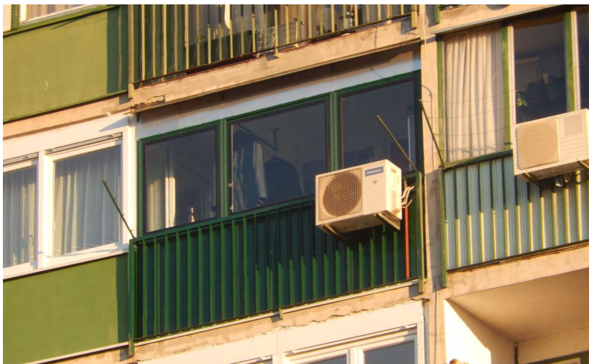
Slika 5: Drveni prozori s dvostrukim staklom
