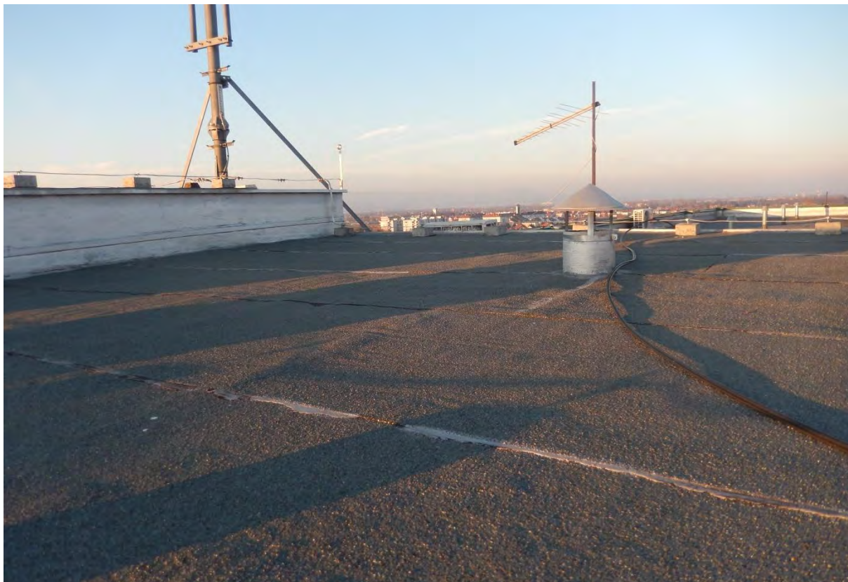
Slika 4: Ravni prohodni krov
