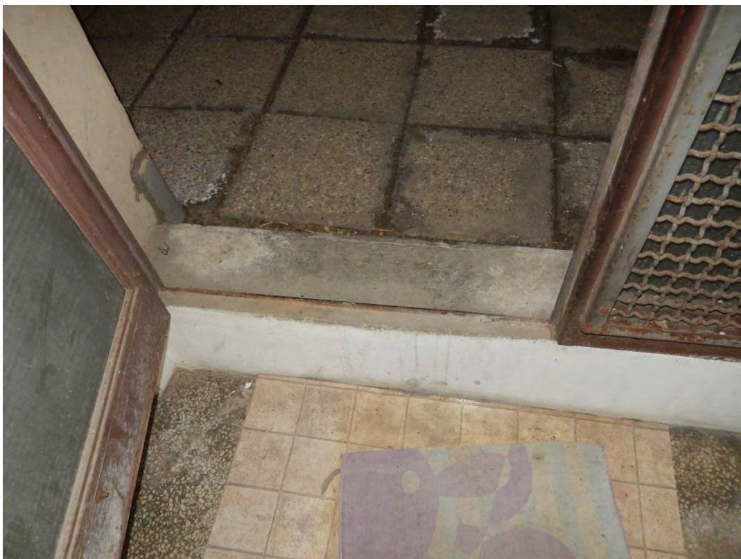
Slika 4: Ravni krov na vrhu nebodera – obloga kulir ploče
