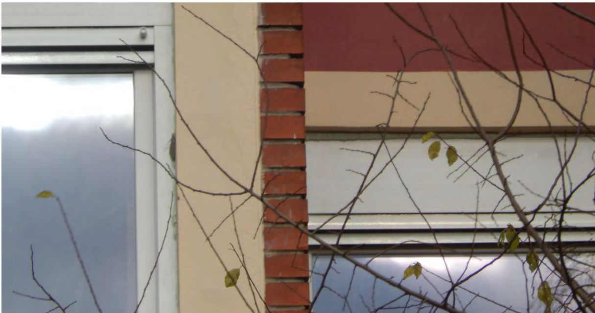
Slika 3: Vanjski zidovi stambene zgrade
