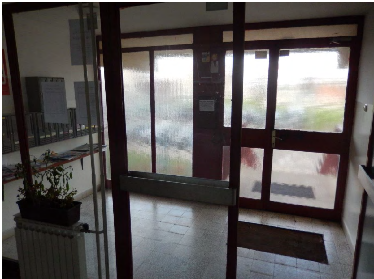
Slika 5: Ulazna vrata u stubište
