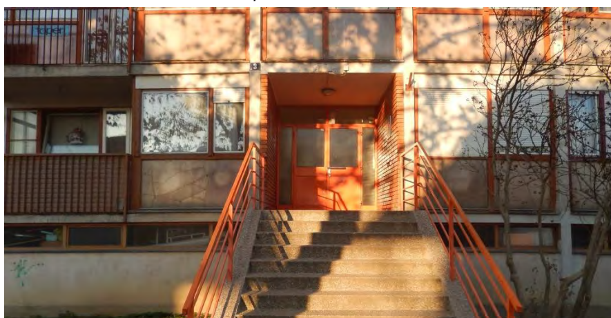
Slika 6: Ulazna vrata u stubište
