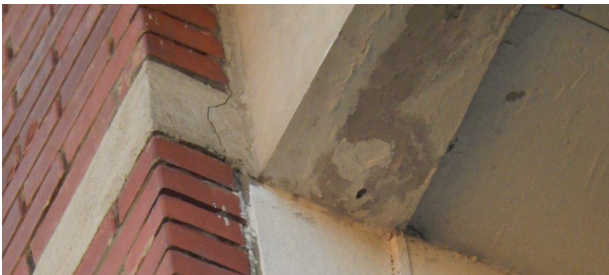
Slika 3: Vanjski zidovi stambene zgrade
