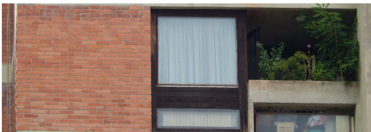
Slika 3: Vanjski zidovi stambene zgrade
