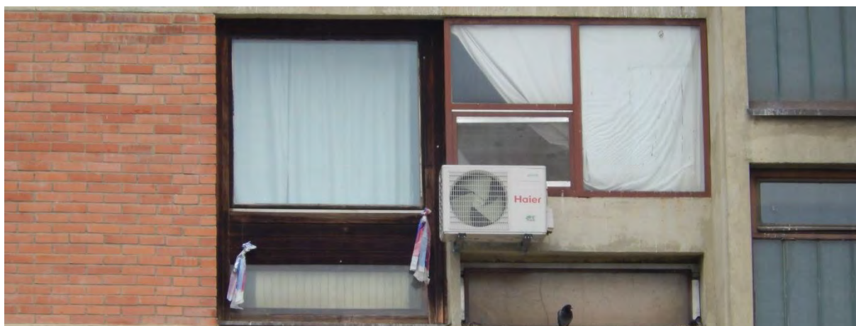
Slika 4: Drveni prozori s dvostrukim staklom
