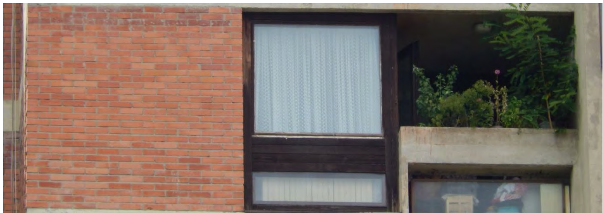
Slika 3: Vanjski zidovi stambene zgrade
