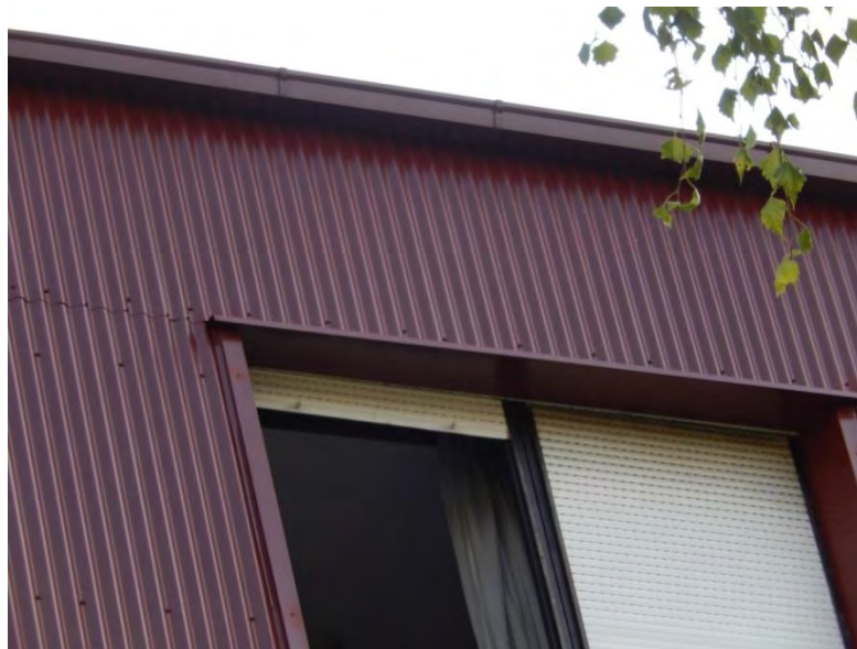
Slika 6: Vanjski zid obložen limom
