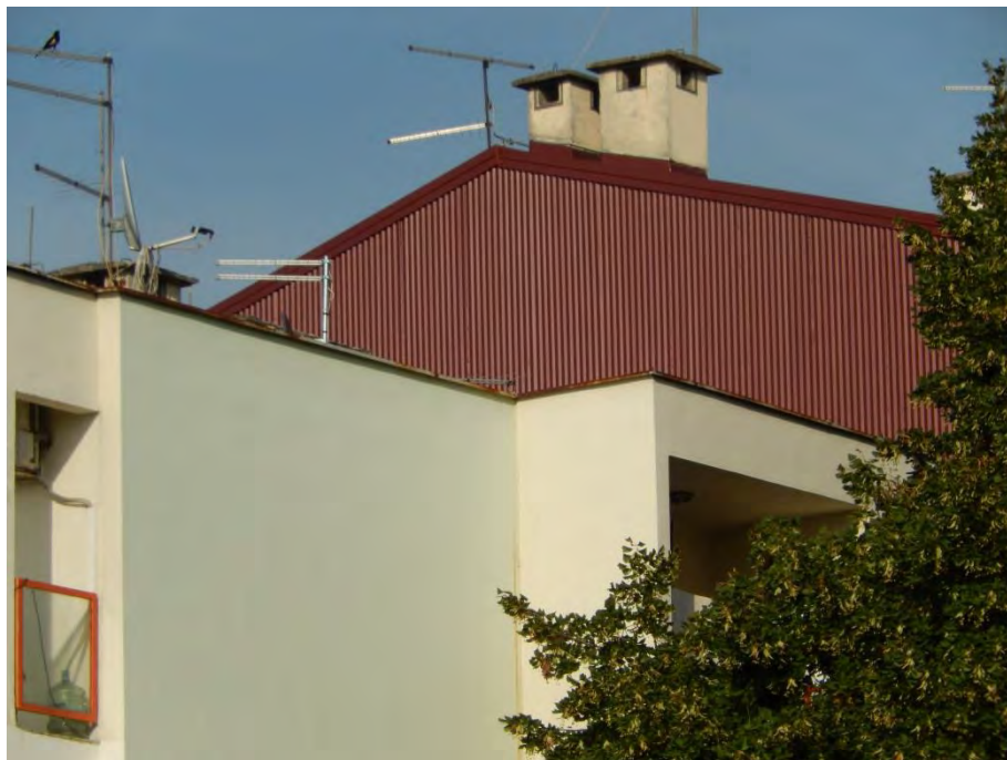
Slika 5: Vanjski zidovi stambene zgrade
