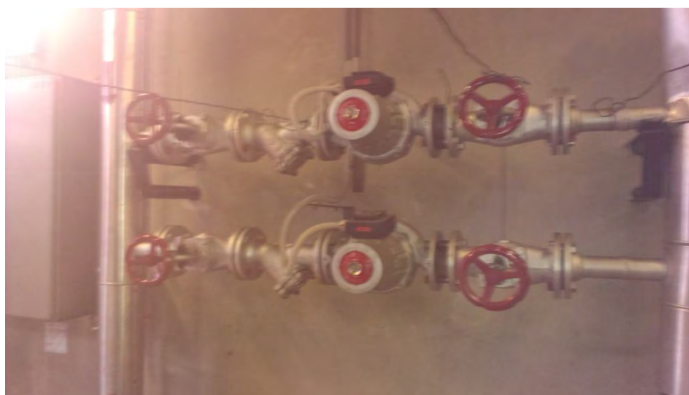
Slika 3. Cirkulacijske pumpe toplinske stanice
