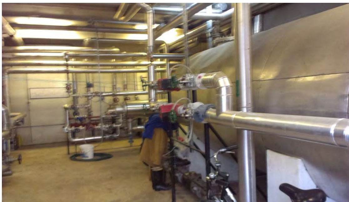
Slika 3. Cirkulacijske pumpe toplinske stanice
