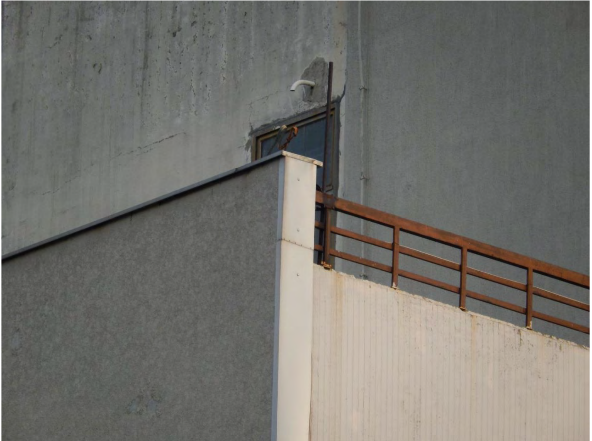
Slika 4: Ravni prohodni krov
