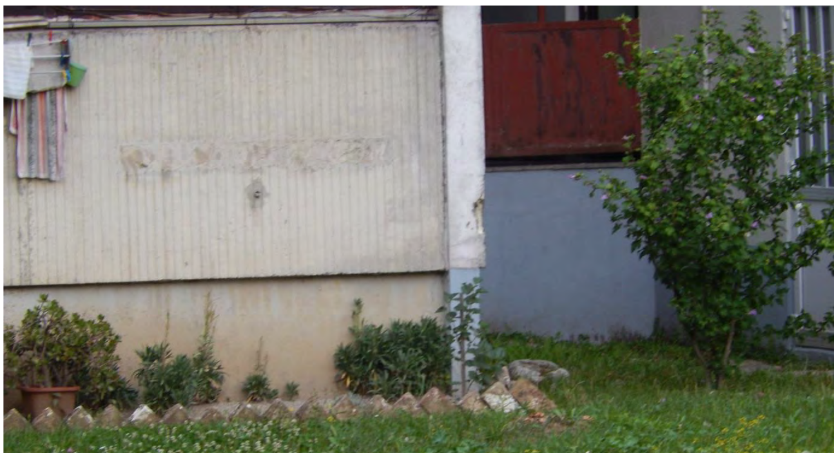
Slika 3: Vanjski zidovi stambene zgrade
