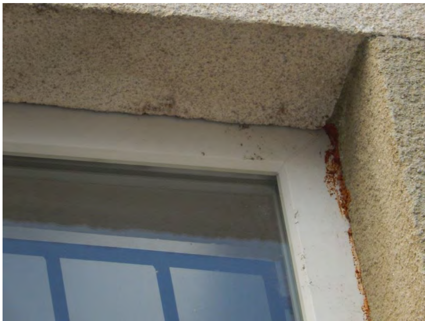
Slika 4: Vanjski zidovi stambene zgrade i ugrađeni novi PVC otvori u stubištu
