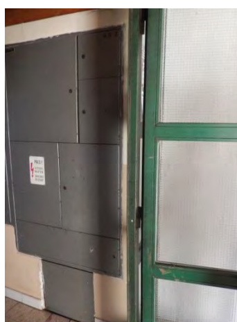
Slika 6: Ulazna vrata u stubište
