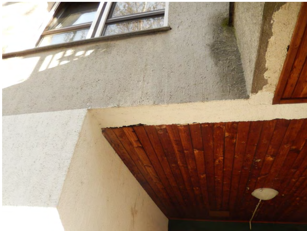
Slika 4: Prolaz kroz zgradu – strop iznad vanjskog zraka
