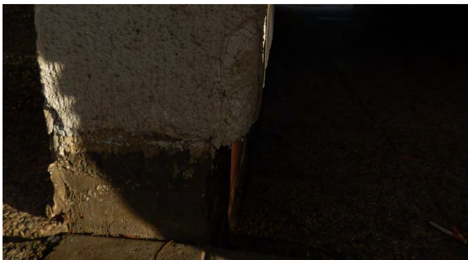
Slika 3: Vanjski zidovi stambene zgrade
