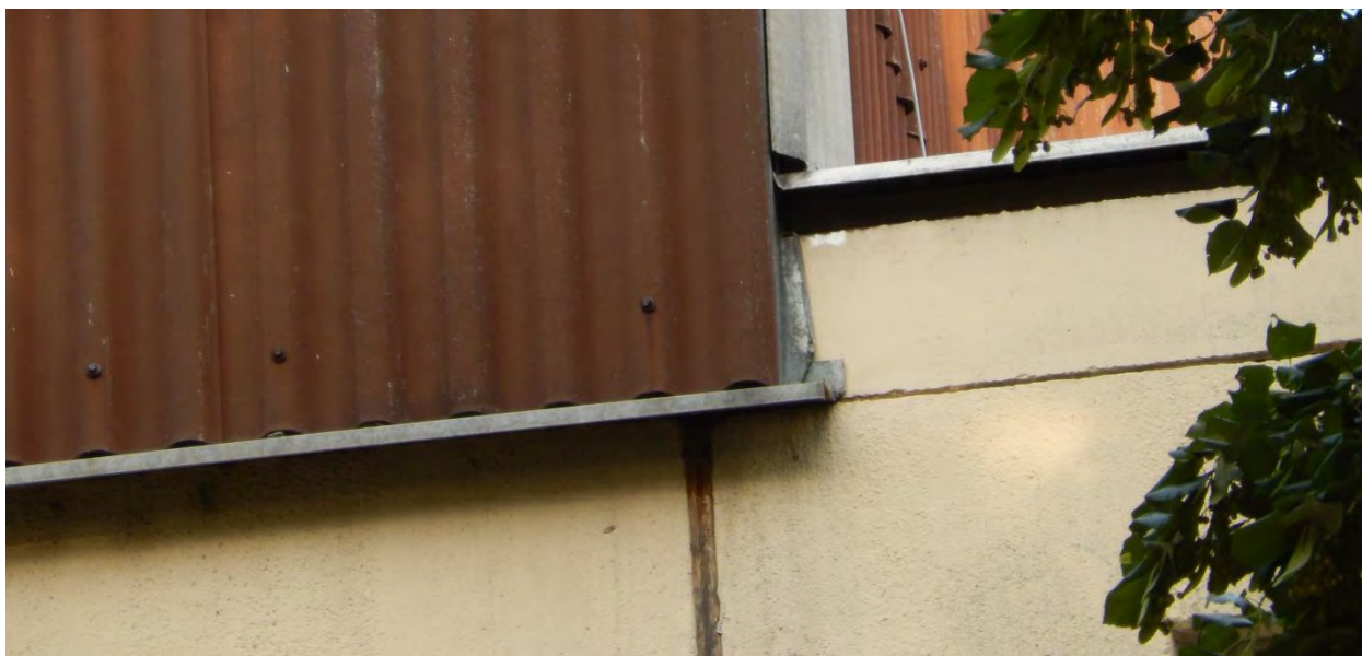
Slika 6. Stambena zgrada Kolareva 41-43 detalj krovišta
