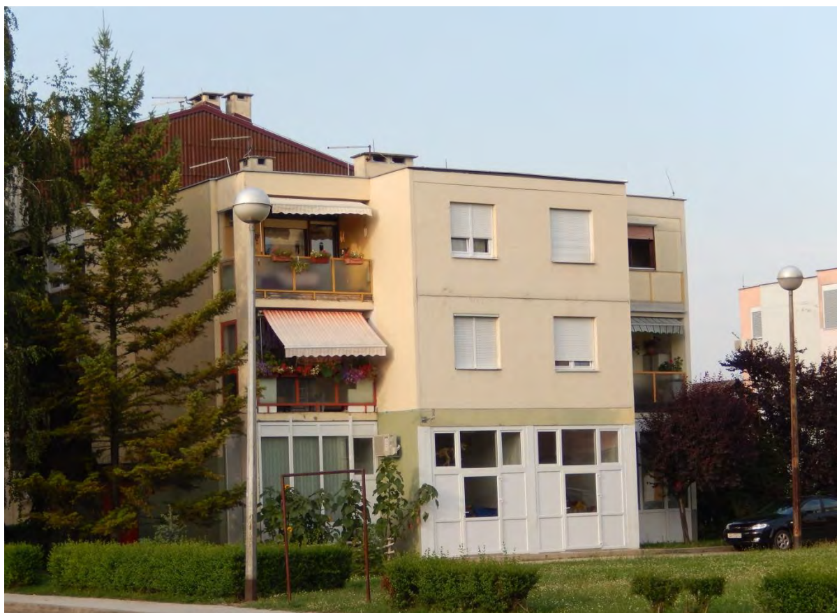
Slika 7. Stambena zgrada Kolareva 41-43 detalj pročelja
