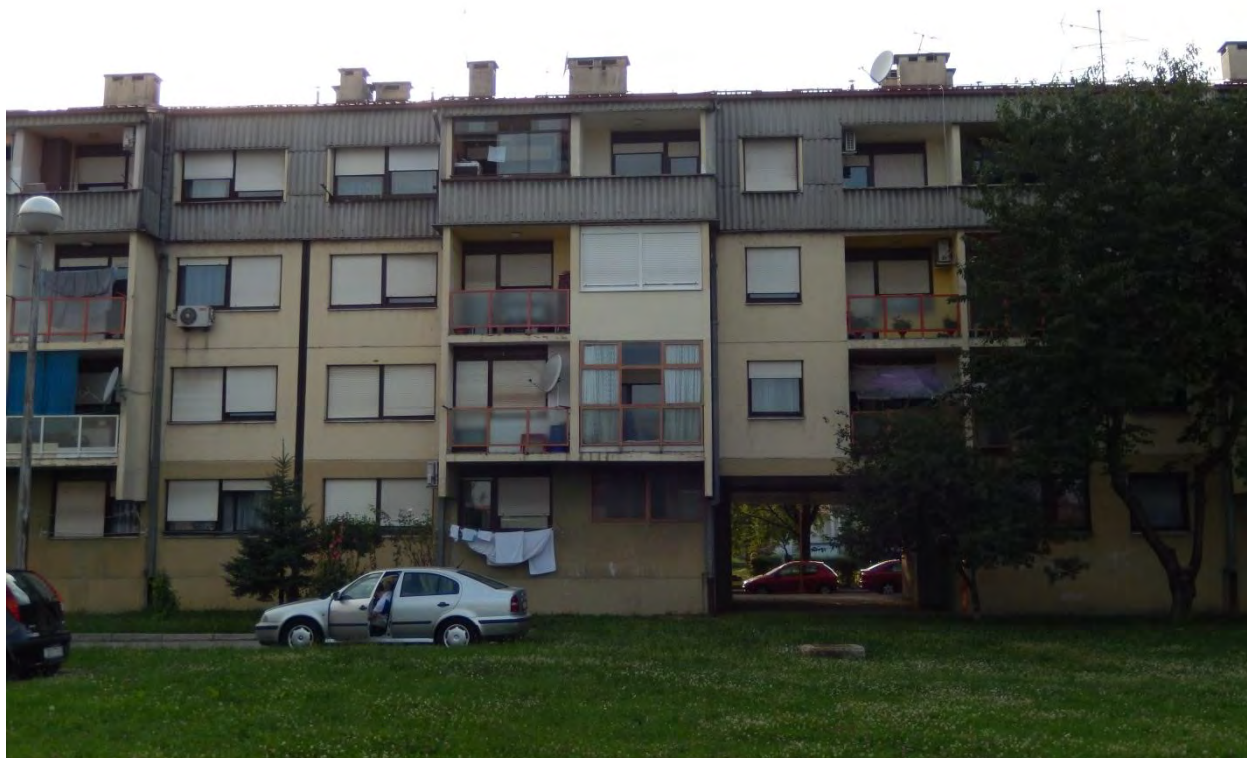
Slika 4. Stambena zgrada Kolareva 41-43 pročelje
