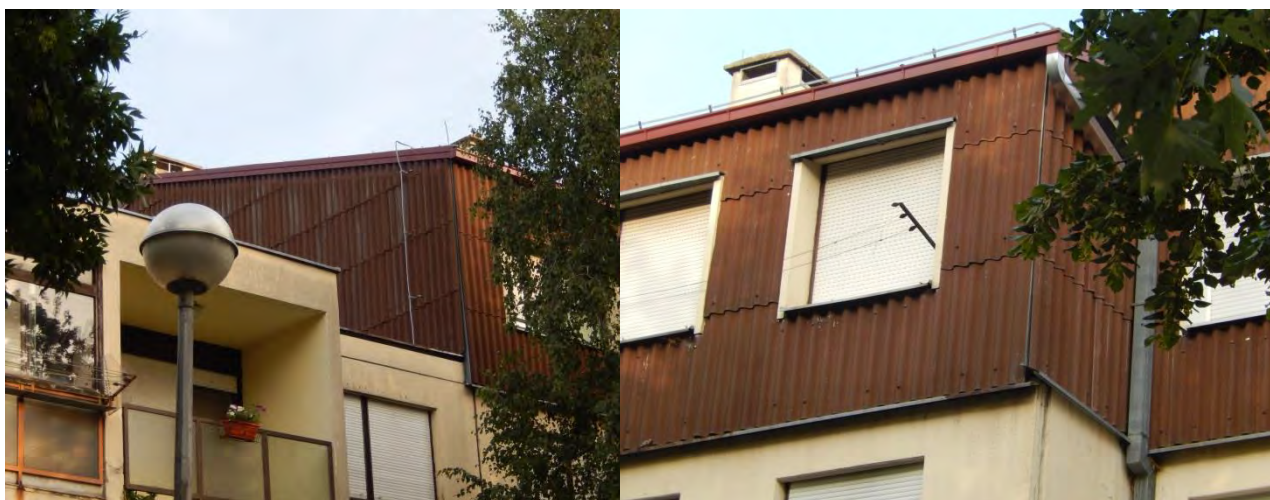
Slika 5. Stambena zgrada Kolareva 41-43 detalj krovišta
